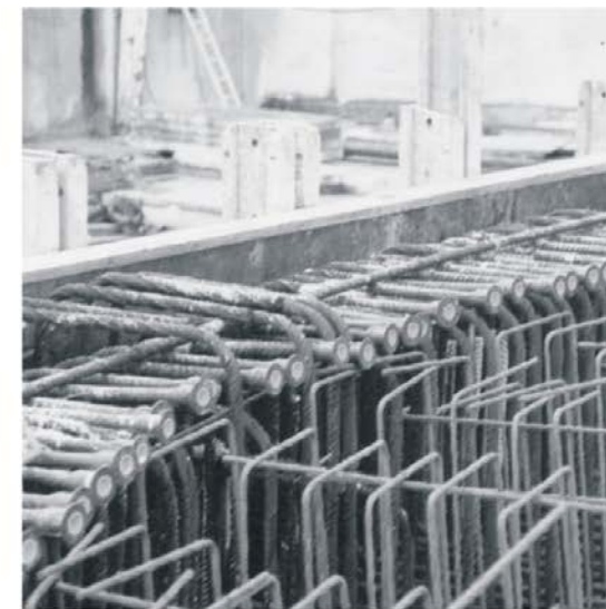
Zbrojenie połączenia ściany i stropu Przedłużenie zbrojenia słupa
