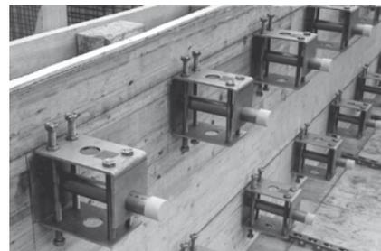
Втулки HSD-CRET зафиксированные к опалубке
